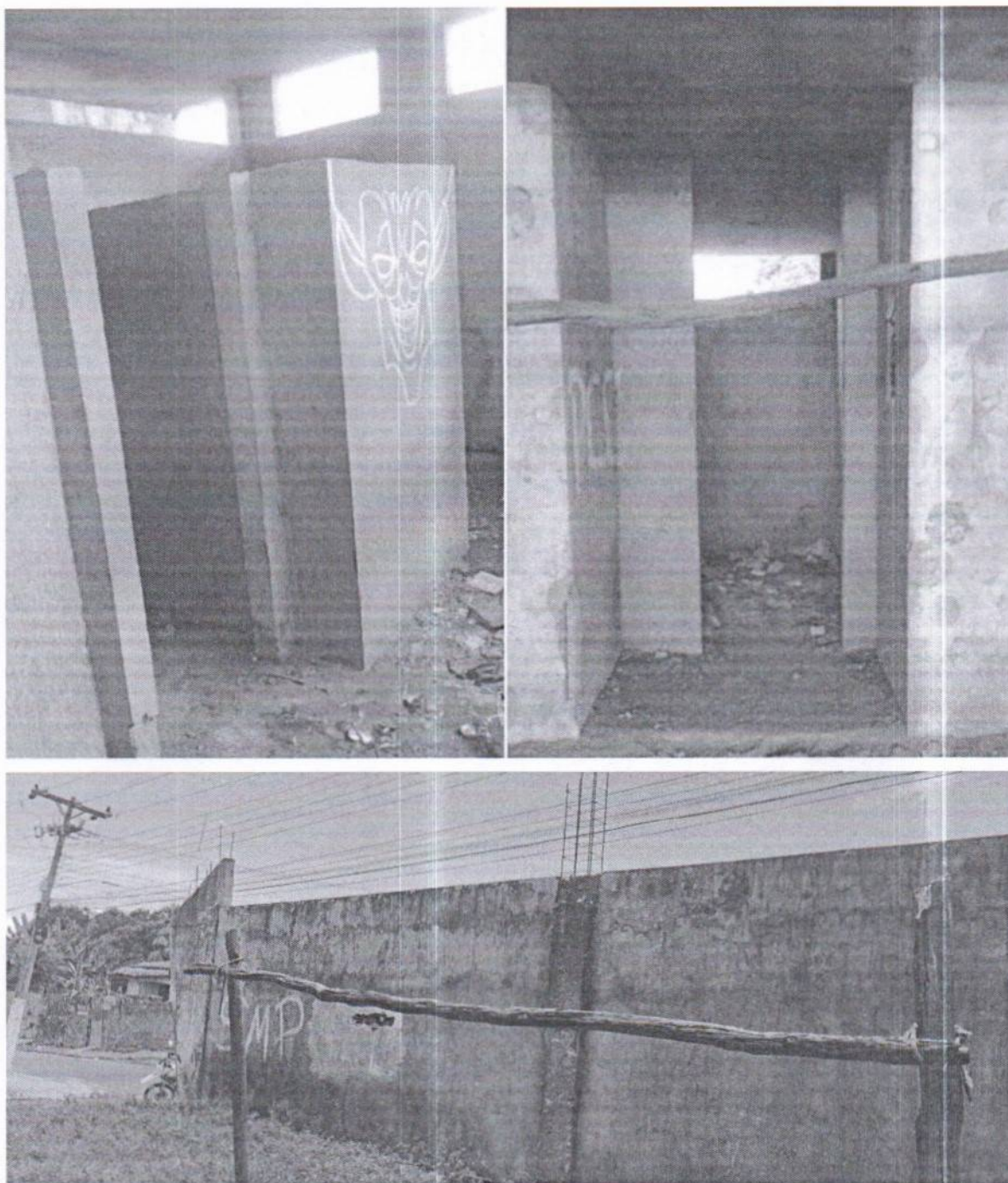
Figura 12,13 e 14 – Paredes executadas revestimento reboco. Fonte : Fotografia in loco, elaboração própria
