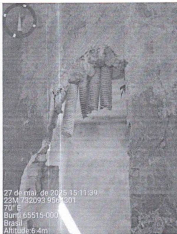
Figura 26 – Eletroduto flexível. Fonte: Fotografia in loco, elaboração própria.
