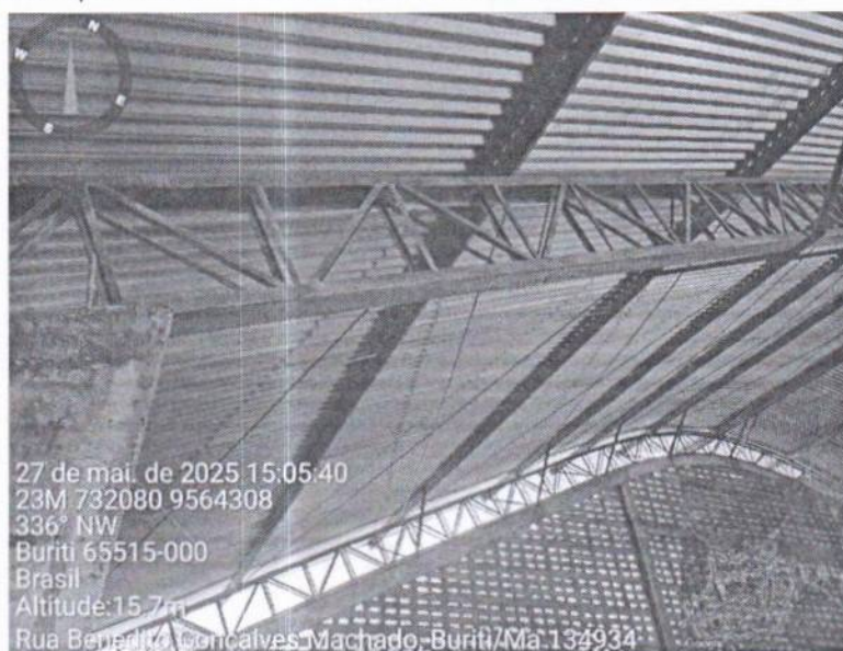
Figuras 40 e 41: Arcos metálicos executados com 50cm ao invés de 80 cm como esta no projeto. Fonte: Fotografia in loco, elaboração própria.
