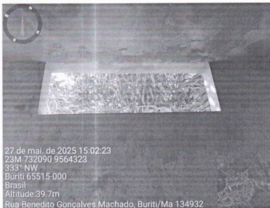
Figuras 36 e 37: Cobogó área do lavatório possui dimensão 110x50 cm, ao invés de 120x50cm.. Fonte: Fotografia in loco, elaboração própria.
