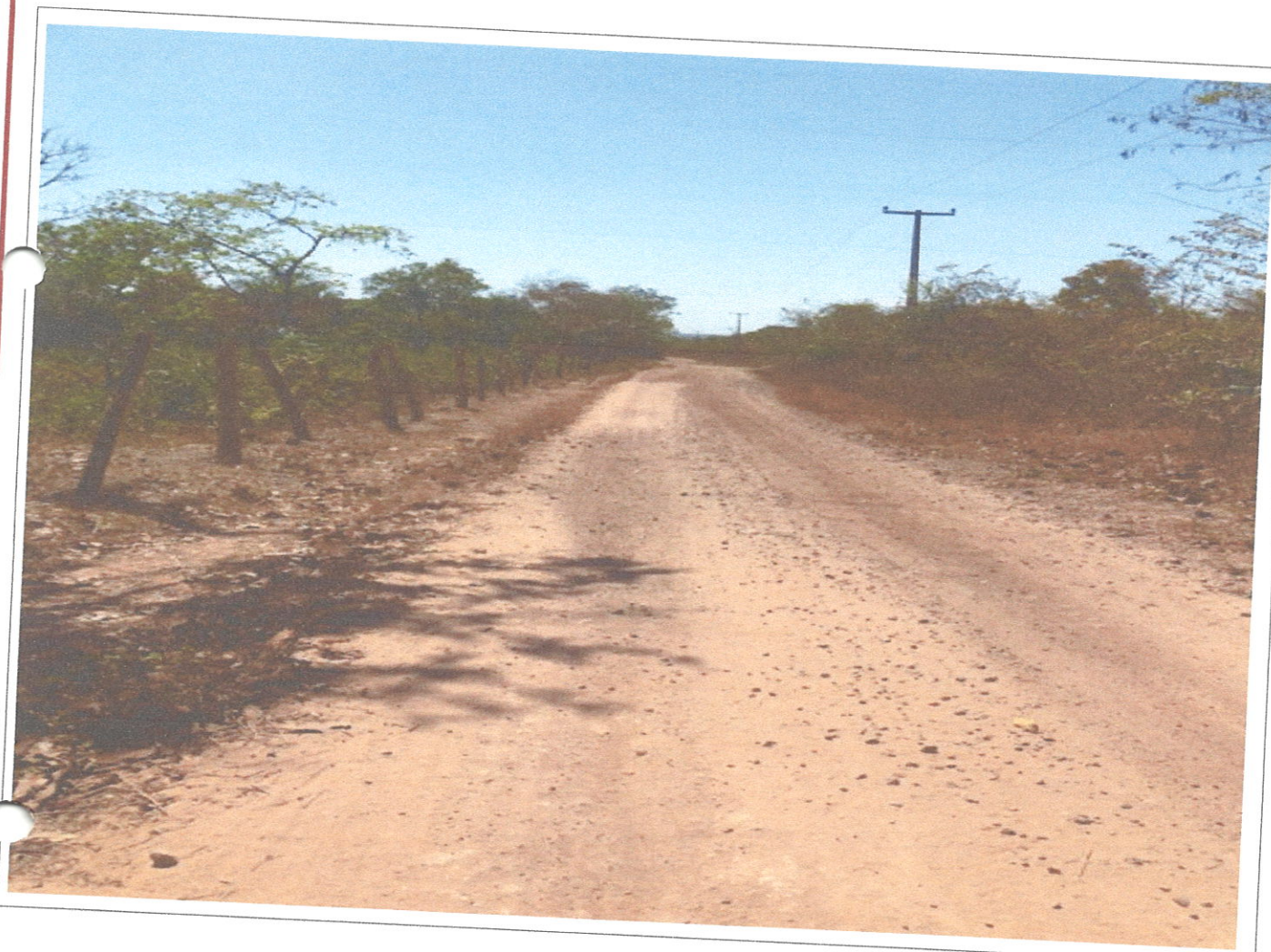
POV. BARRA NOVA – FIM – SITUAÇÃO DA ESTRADA (E= 745407.00 N= 9562951.00)
