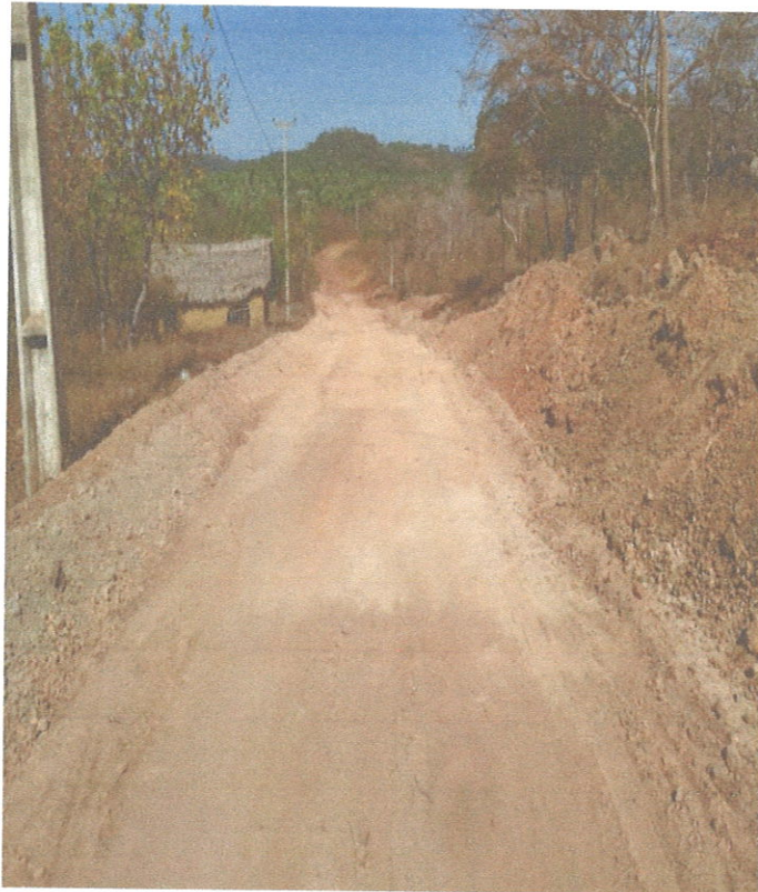
SITUAÇÃO DA ESTRADA (E= 737693.84 N= 9563013.64)
